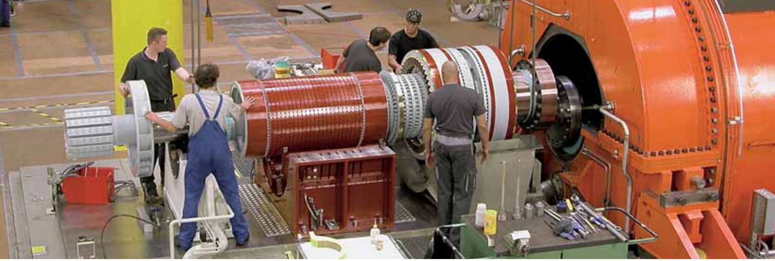
Generator Die neue Erregermaschine wird eingebaut.
