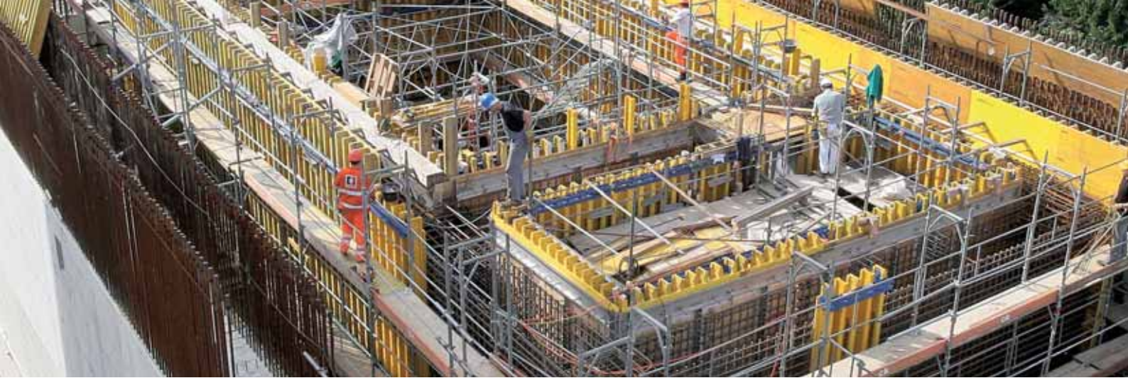
Brennelementlagergebäude Arbeiten auf der Grossbaustelle Mitte Oktober 2006
