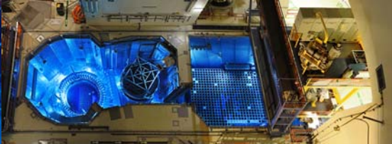
Nr. 1- Réacteur Nr. 2- Piscine du combustible Nr. 3- Piscine de rechargement
